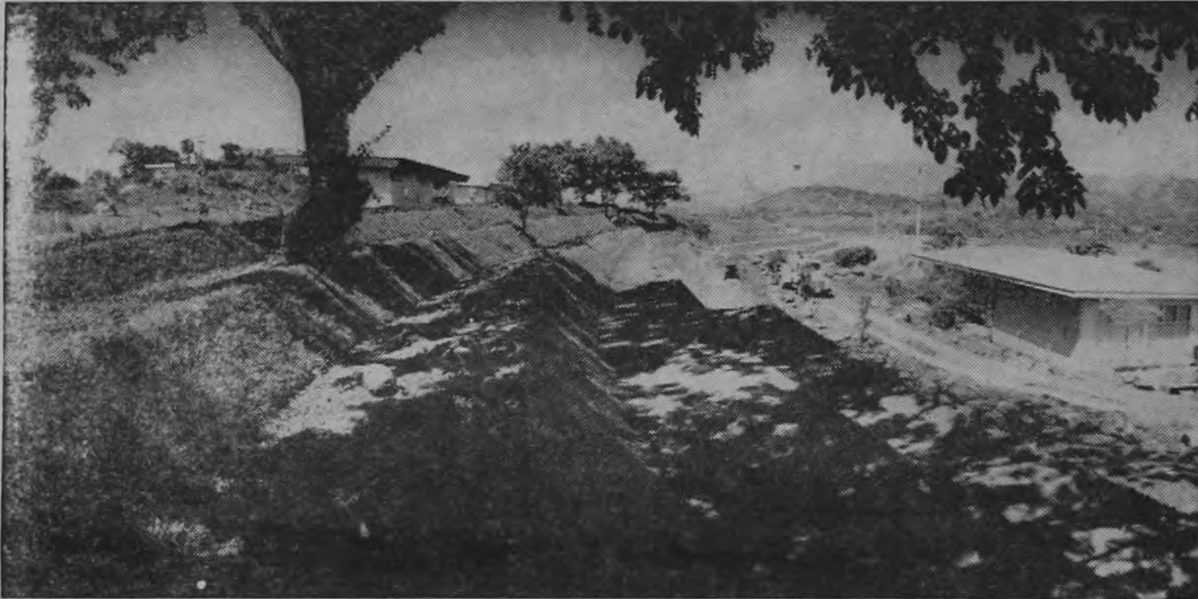
SISTEMA DE TERRAZAS empleado en la realización de los trabajos de reforestación y embellecimiento de los terrenos en donde se encuentra ubicada la Planta Hidroeléctrica de La Garita. Estos trabajos han sido ejecutados por el ICE con la colaboración de expertos del Ministerio de Agricultura. Aparte de su valor práctico para el mantenimiento general de la importante central, la obra comprende el cumplimiento de aspectos relacionados con las obligaciones que la ley le señala al Instituto en materia de defensa de los recursos naturales del país y del racional aprovechamiento de los mismos.
